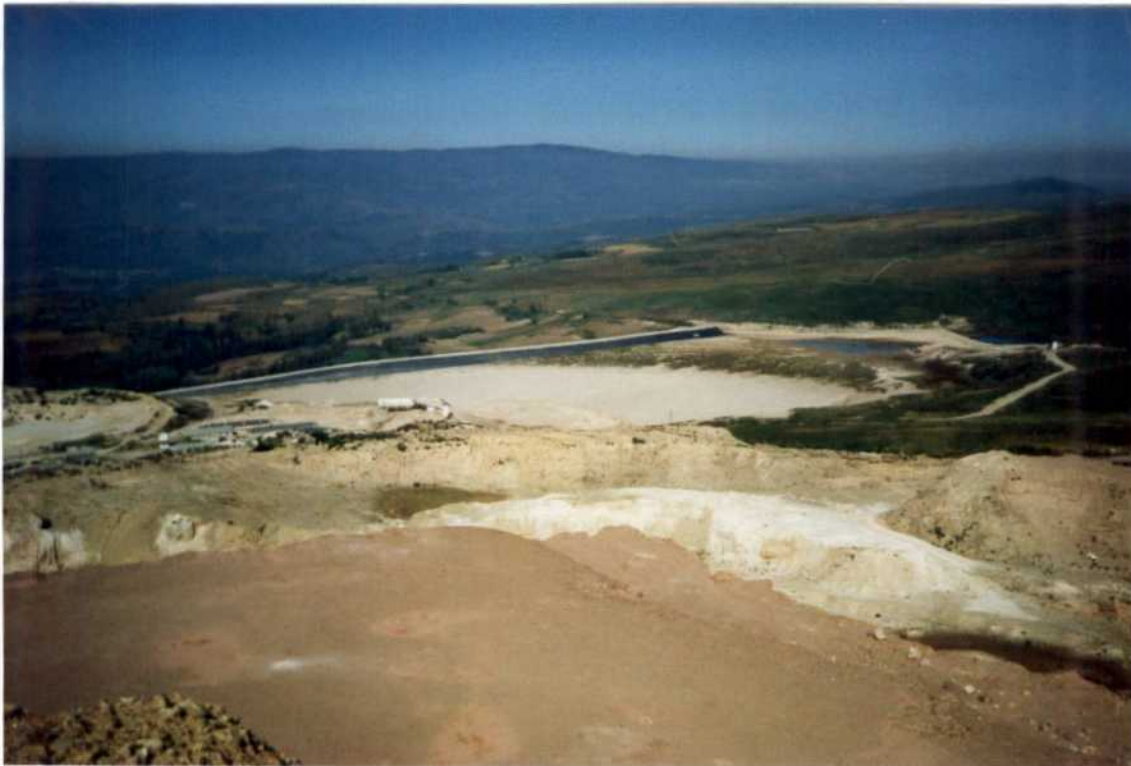
FOTO Nº 13.- Balsa de Estériles: (9-11- 7-17)
