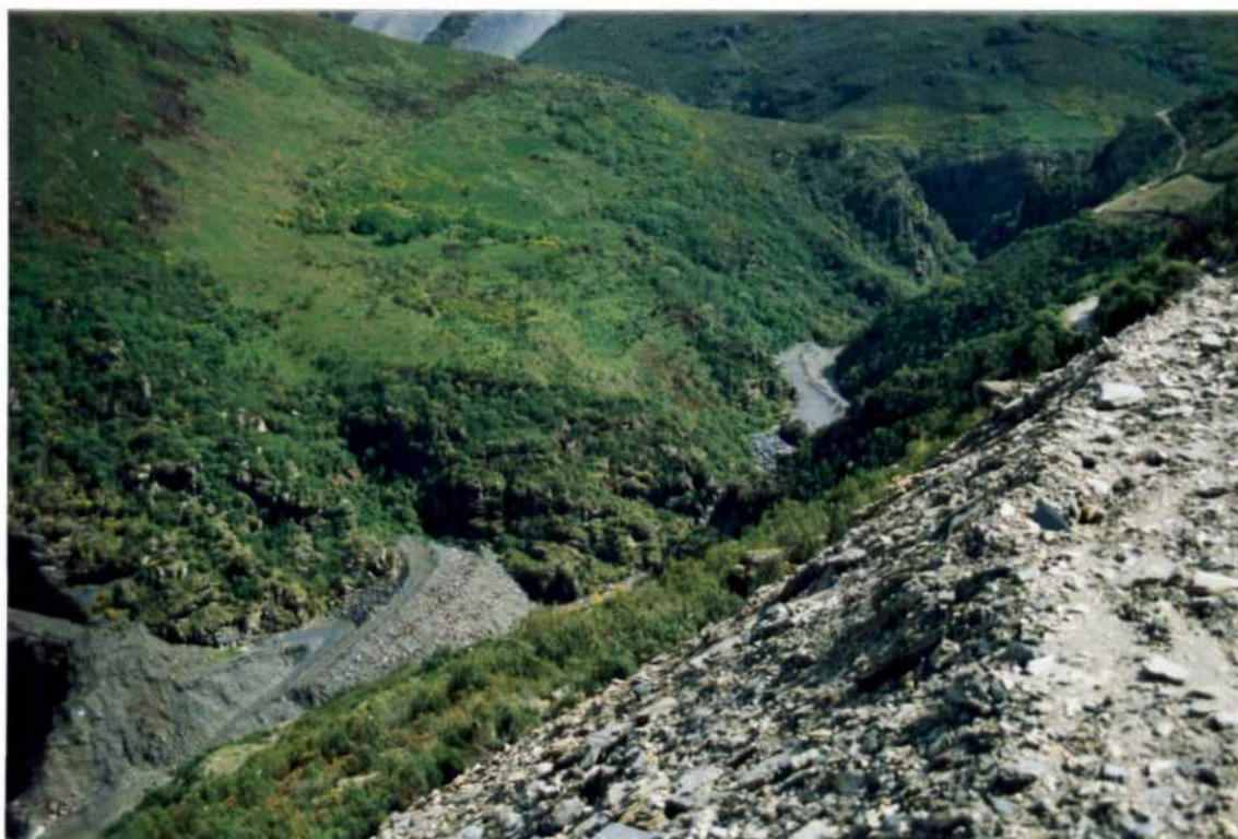
FOTO Nº 7.- Vertido de escombros a lo largo del cauce del río Riodolas
