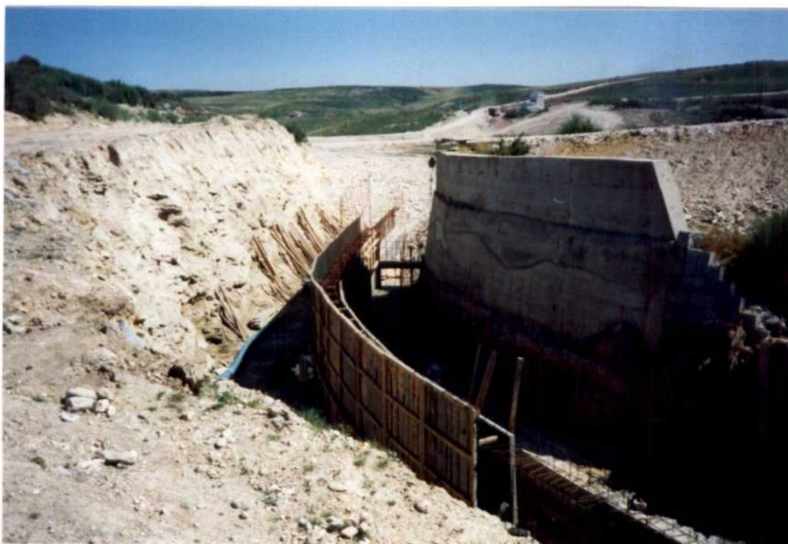
FOTO Nº 16.- Construcción del aliviadero de la Balsa de Estériles.
