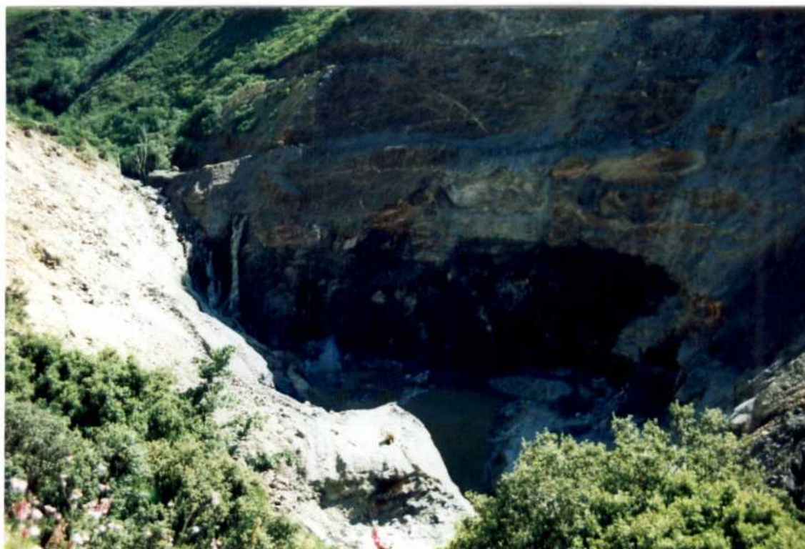
FOTO N° 9.- Realización de labores en el mismo cauce del río Valborrás
