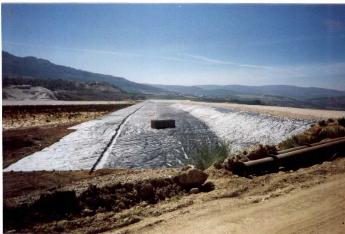
FOTO N° 15.- Colocación de una capa de material impermeable sobre el dique.
